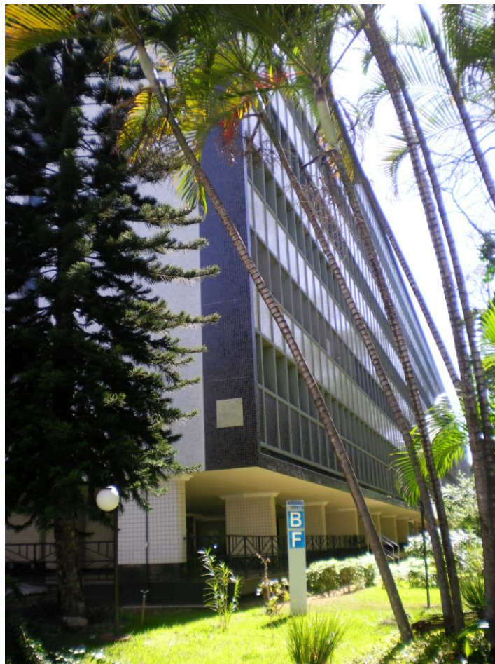
Fig. 1 - Prédio onde Renato Russo morou em Brasília: Bloco B da Superquadra 303 (SQS 303) da Asa Sul do Plano Piloto (Foto: Marli Rosa)
